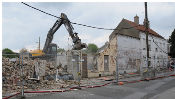
Démolitions. Gravelines, rue Vanderghote en 2014
