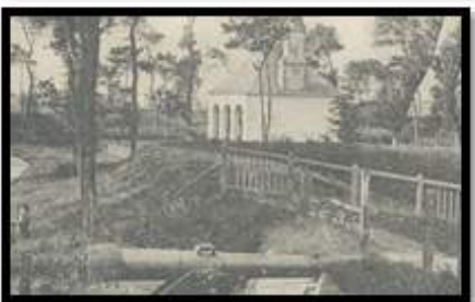
Corps de Garde du Moulin (photo 1920). Ce corps de garde construit en 1771 est le plus petit poste de surveillance de la place. Il ne compte qu'une seule salle avec cheminée, à l'étage, un grenier à foin et à l'extérieur, une galerie pour abriter la sentinelle.
