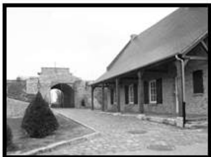
Corps de Garde du Château (photo 1980). Avec son portique de bois et sa lucarne surmontée d'un fronton triangulaire, le corps de Garde du château, paraît contemporain des autres de la cité.
